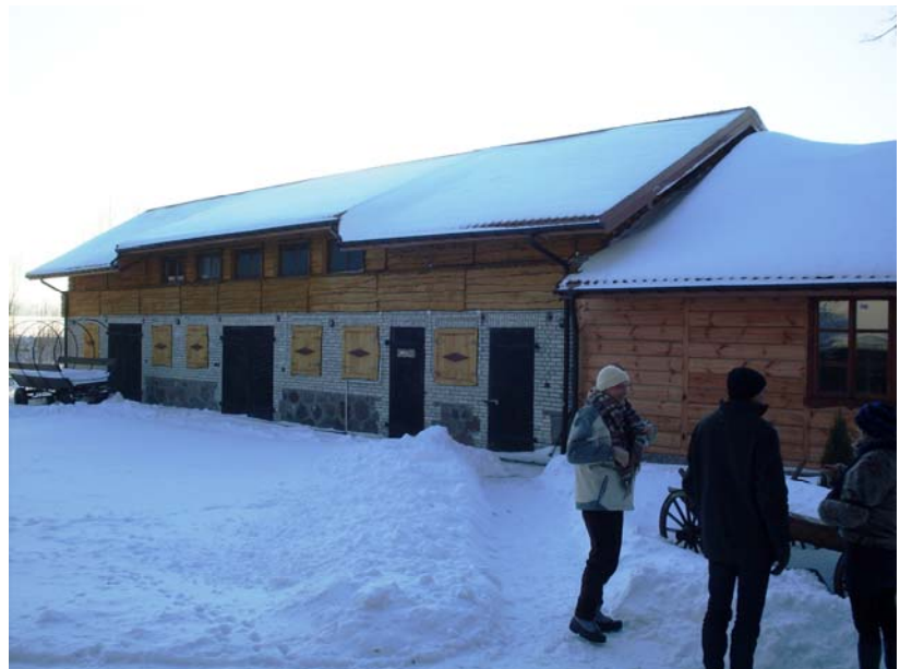
Bild 5: Nebengebäude, im Erdgeschoß Wirtschaftsräume, das ganze Obergeschoß ist ein Freizeitraum (siehe nächstes Bild)
